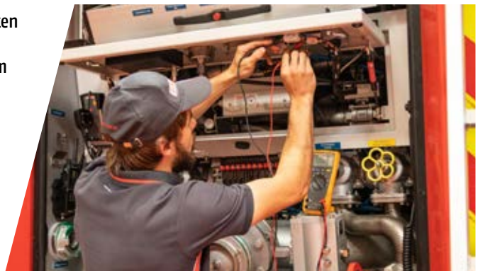
Fehlersuche am Bedienerpult der Einbaupumpe
